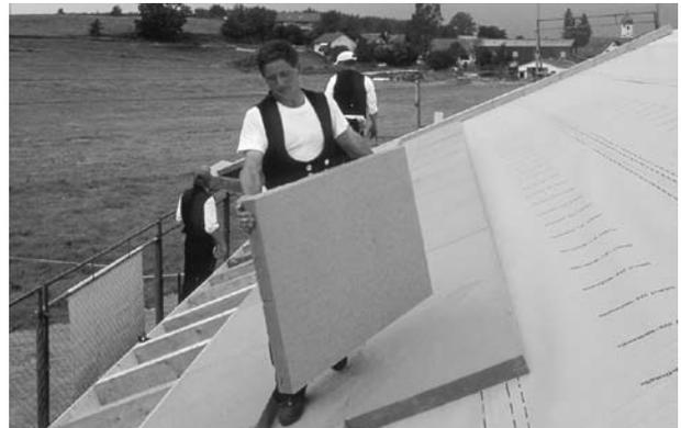
Verlegung der handlichen, stabilen PAVATHERM-Platten als Aufsparrendämmung
