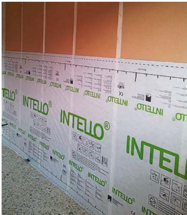
L'applicazione di manto igrovariabile® INTELLO in monostrato, con sormonto di 15 cm. Il manto verrà fissato a soffitto e pavimento con graffe su struttura in legno, con ORCON MULTIBOND per un incollaggio immediato su strutture in latero-cemento. INTELLO può essere fissato inoltre al pannello con nastro biadesivo DUPLEX (con primer TESCON RP) o fissato ai listelli interposti con graffe.
