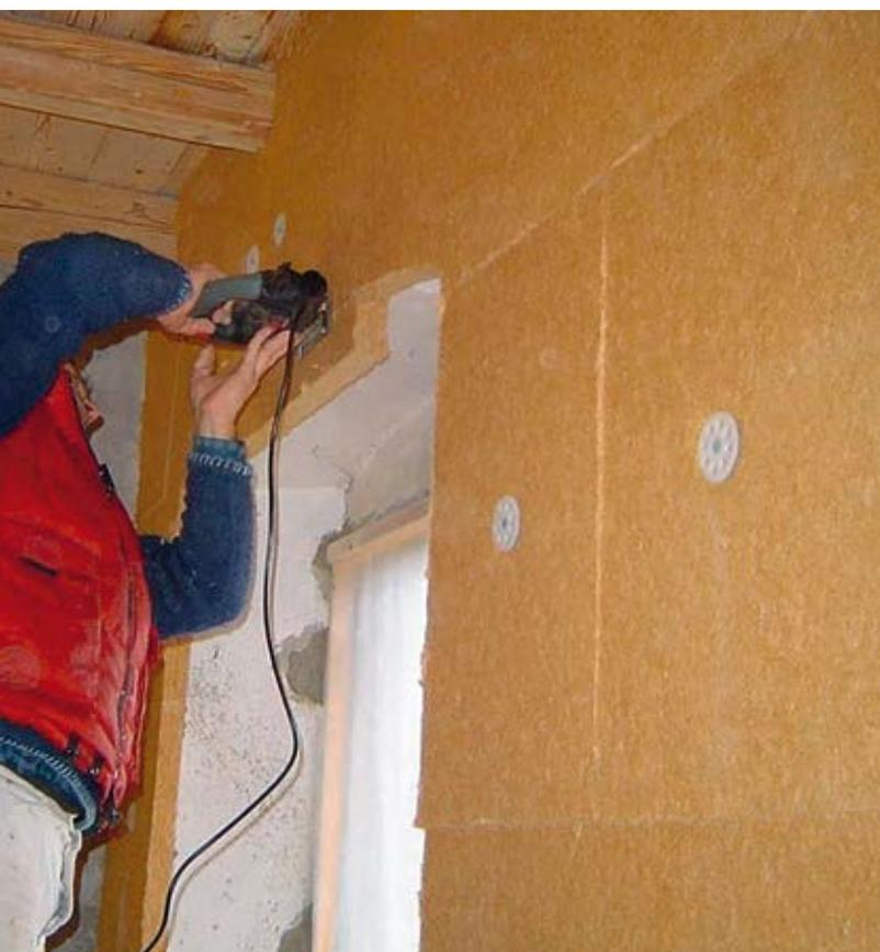
Il pannello NATURATHERM verrà applicato con giunti ben accostati a copertura dell'intera parete, comprese le spalle ed il celino delle aperture. Il fissaggio sarà meccanico con tasselli STR-U di Naturalia-BAU, 2 per pannello. Per particolari esigenze di carico nella contro-parete saranno previsti listelli in legno o profili metallici del spessore dell'isolante NATURATHERM, posati in orizzontale od in verticale ad interasse 60 cm, a seconda delle esigenze di portata della contro-parete.
