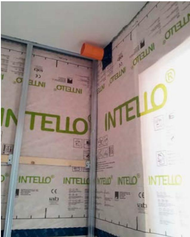
Il sistema di isolamento IGROSAN prevede quindi la posa in opera di controparete su orditura autoportante o fissata su profili predisposti nello spessore di NATURATHERM. L'orditura sarà realizzata con profili a secco, metallici o in legno, con le sezioni necessarie per la sollecitazione meccanica e l'altezza della controparete. Nello spazio tra i profili potrà essere inserito NATURAFLEX fino a 40 mm di spessore per migliorare le prestazioni termiche ed acustiche del sistema.
