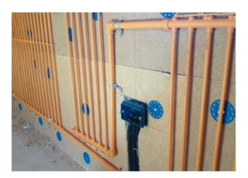
Le scatole di derivazione sono fissate con malta a presa rapida, avendo cura di coprire interamente la scatola, lo stesso fissaggio a presa rapida è utilizzato per fermare i tubi corrugati, il resto della scanalatura sarà riempito con fibre e intonaco Claytec COLLANTE-RASANTE, o con termo intonaco. I tappi proclima Stoppa sono utilizzati per garantire la tenuta all'aria dei cavi elettrici interni al tubo corrugato.
