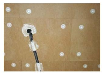
L'inserimento di impianti nel sistema NATURADENTRO avviene dopo il fissaggio dei pannelli, è importante contenere il numero di passaggi al minimo indispensabile.
