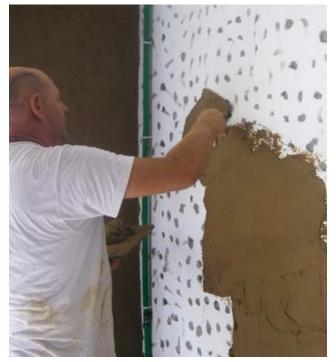
La superficie della parete su cui applicare il sistema NATU-RADENTRO dovrà essere igroscopica, cioè essere in grado di assorbire acqua. Nel caso di vecchi intonaci a calce esistenti si rimuoverà la pittura esistente con fresatrice. Sono da rimuovere anche smalti, piastrelle, carta da parati ed intonaci in gesso. Per migliorare l'adesione in caso di intonaci misti si prepara la superficie con picchettatura fitta e pulizia della parete.
