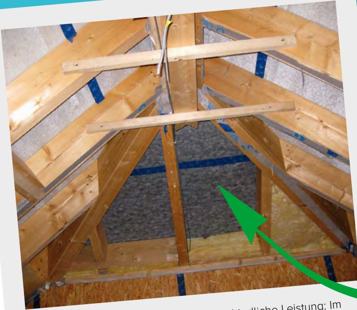
Ein Dach, gleiche Bedingungen, unterschiedliche Leistung: Im Walm porenfreie SOLITEX MENTO Bahn.
