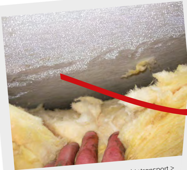
Mikroporöse Bahn: Kein aktiver Feuchtetransport > nasse Konstruktion
