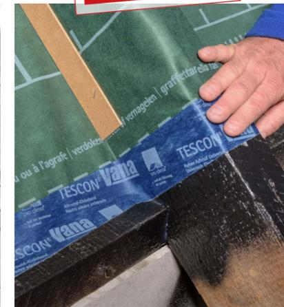
Auch die Ertüchtigung des Untergrundes, z. B. bei einer Sanierung, ist möglich. AEROSANA VISCONN hat einen feuchtevariablen Diffusionswiderstand und kann daher sowohl auf der Innen- wie auch auf der Außenseite von Bauteilen eingesetzt werden.
