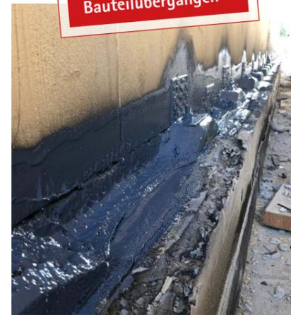
Bauteilübergänge mit unterschiedlichen Materialien und vielen Ecken und Kanten – einfach mit AEROSANA VISCONN überstreichen und dicht.
