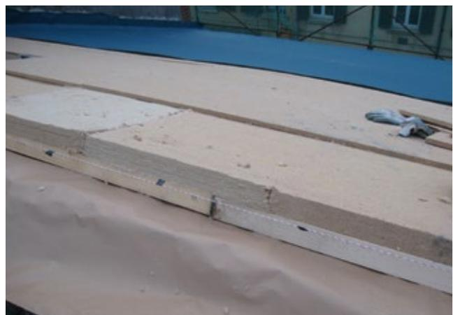
Einsatz von Leisten zwischen der ersten Schicht zur Befestigung der Entlüftung auf schwierigen Konstruktionen (Tonziegel, gemischte Deckenaufbauten, Renovierungen)
