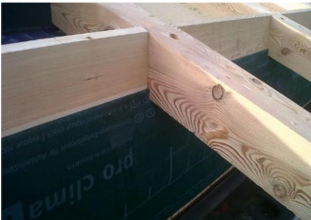
Aufbordung mit INTESANA in der Fassade. Beachtenswert das Wandanschlussprofil zur Aufnahme der Dämmung.
