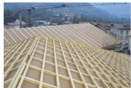
Dachfirst mit durchgehend verlegter Dichtung, mit belüfteter Unterdeckung. Lattung für die Befestigung von Dachpfannen oder Dachziegeln laut Anordnung der DIN EN 6940 und Zivilschutzvorschriften.
