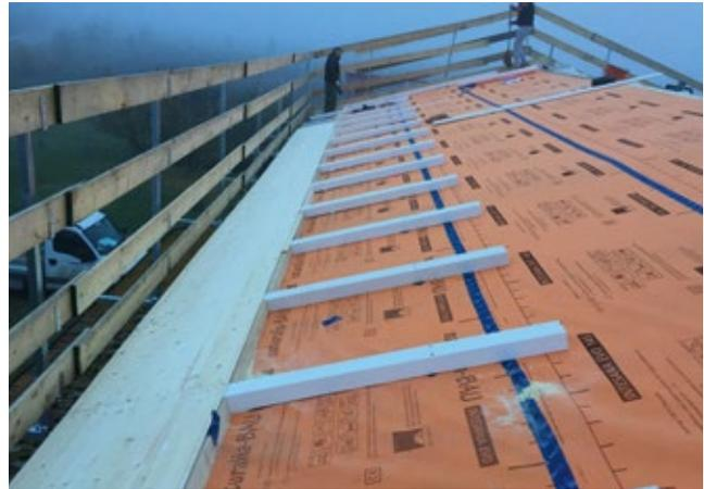
Das Dachsystem mit Kontersparren ist die einfachste Lösung. Quelle: Arch. Battistini)
