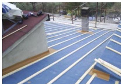
ANSCHLUSSBAHN in brauner Farbe zur Verstärkung der kritischen Dichtungspunkte STAMISOL
