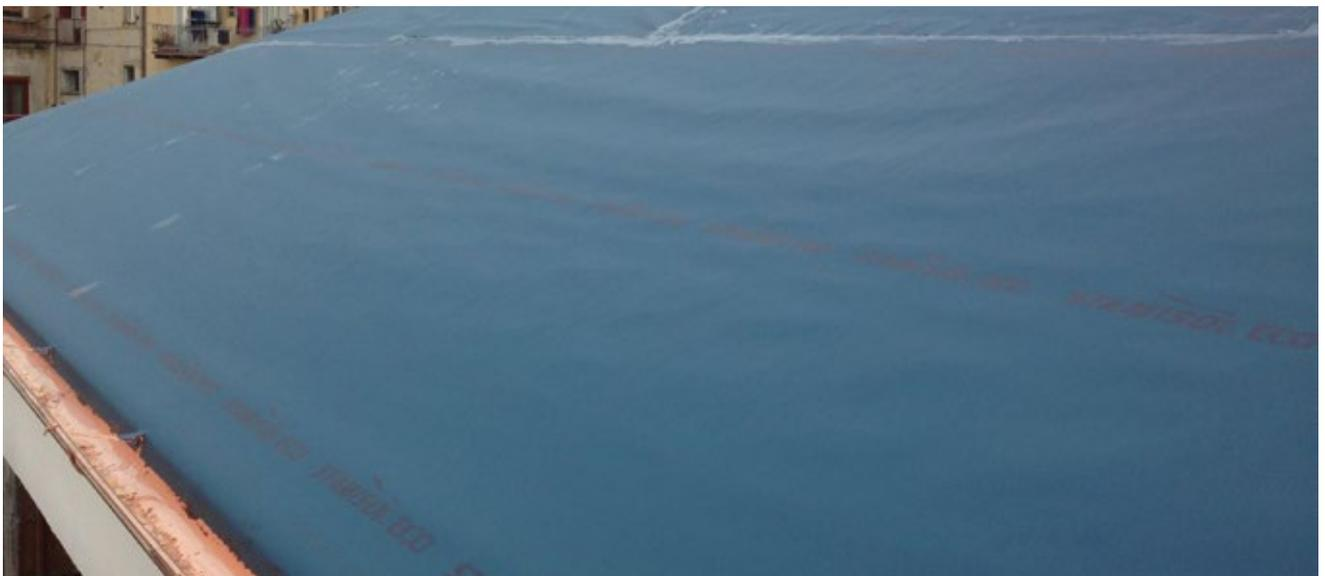
Dichtungslösung Stamisol, UV-beständig und bis zur Dachtraufe verlegbar. Zu den bis zur Dachtraufe verlegbaren Produkten zählen: STAMISOL ECO, STAMISOL DW, STAMISOL PACK 350, STAMISOL PACK 500
