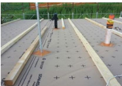
Details der luftdichten Verklebung von verschiedenen durchgehenden Elementen: NAGELDICHTUNGSBÄNDER und ANSCHLUSSMANSCHETTEN
