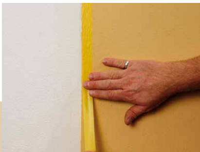
Erneutes Abkleben nach Trocknung
