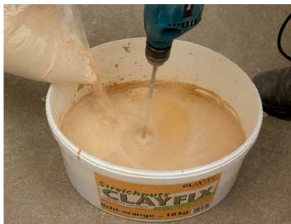
Einrühren des Eimerinhalts in Wasser
