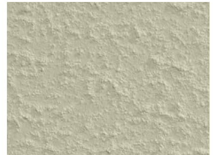
Struktur einer gut vorbereiteten Gipskartonplattenfläche
