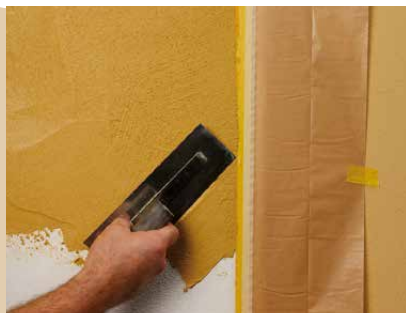
Auftrag der zweiten Farbe
