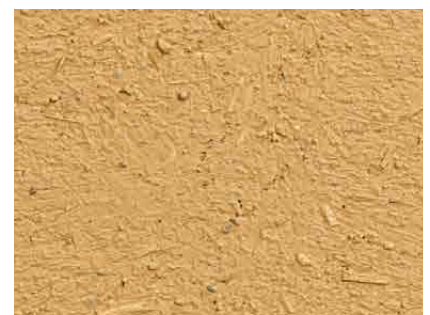
Struktur einer gut vorbereiteten Fläche aus Lehm-Unterputz
