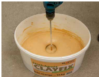
Nach 30 Minuten Quellzeit gut durchrühren
